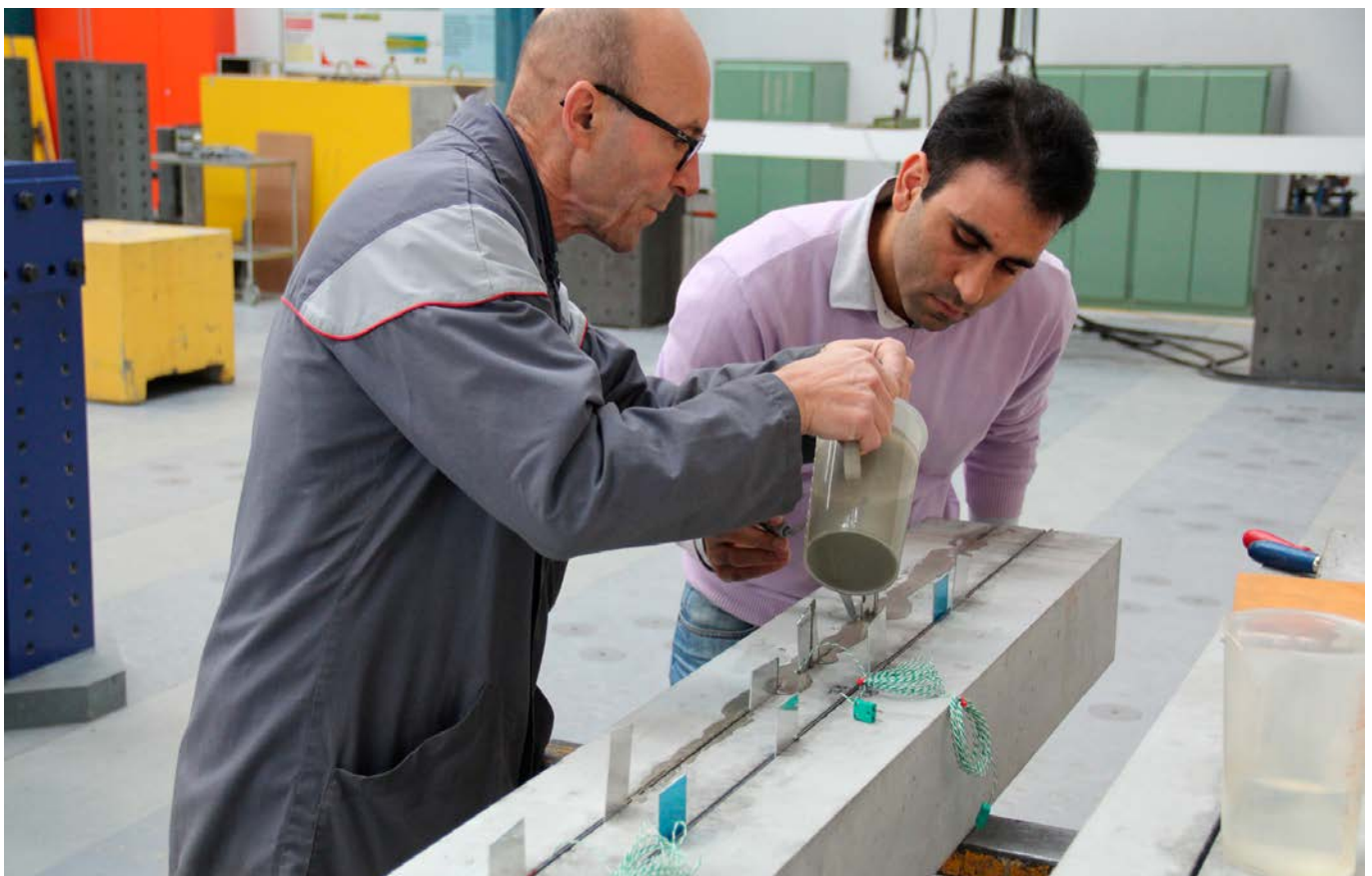
Zwei FeSMA-Lamellen werden in Spannbeton eingebettet und mit Mörtel fixiert. (Bildquelle: Empa)
